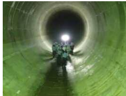
雨水貯留管（東京都）
