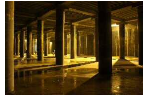
貯留施設（福岡市）
