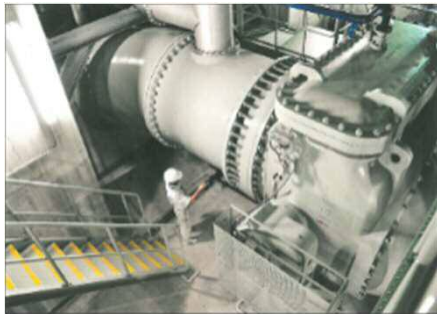
雨水ポンプ（広島市）
