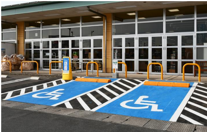
床面を青色に塗装した事例
