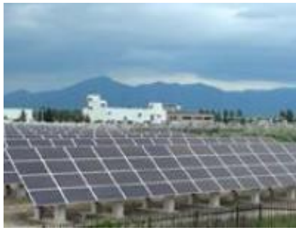
山形県 山形浄化センター
