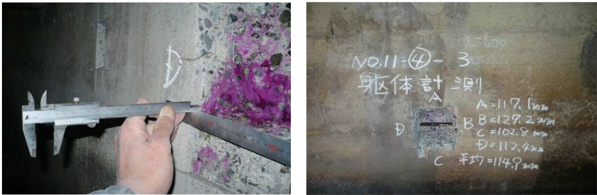
図 2-12 中性化深さの測定
