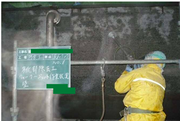
図 2-13 劣化部除去工(超高圧水処理)
