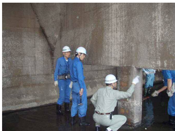
図 2-5 局職員等による目視・打音
