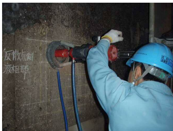
図 2-6 専門業者によるコア抜き
