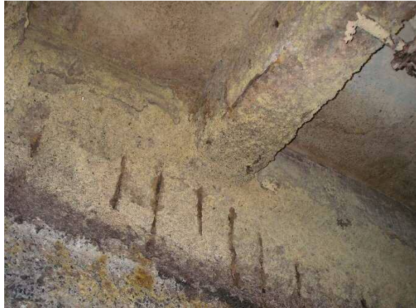
図 2-1 化学的侵食事例(返流水槽)
