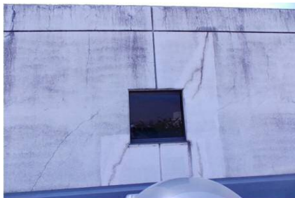
図 2-8 外壁仕上の劣化事例
