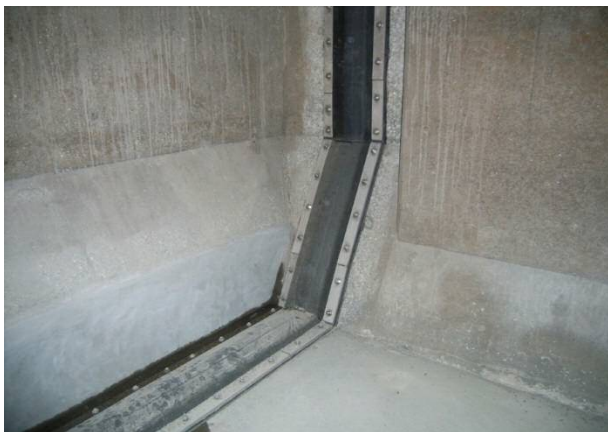
図 1-4 後付け式伸縮可とう継手の設置
