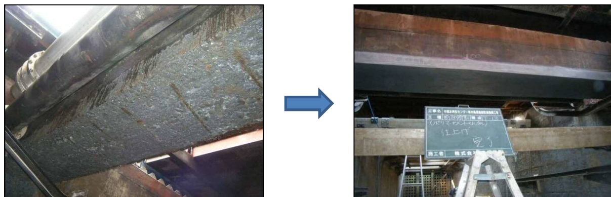
図 2-10 断面修復(ポリマーセメントモルタル吹付け)事例
