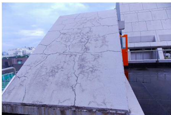
図 2-7 屋上防水の劣化事例
