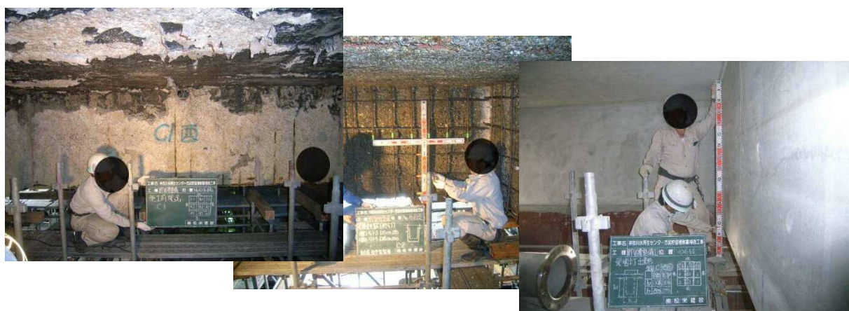
図 2-11 耐震補強と合わせた防食事例
