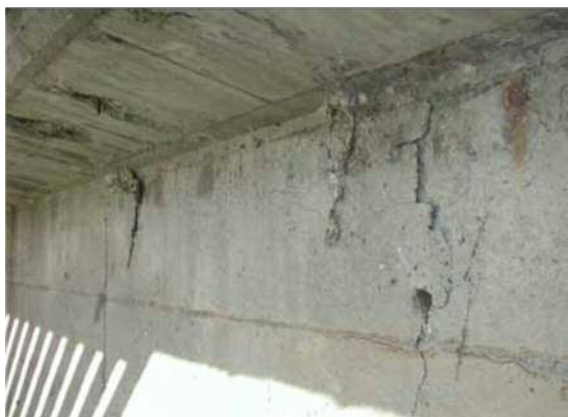
図 2-3 中性化事例(反応タンク)
