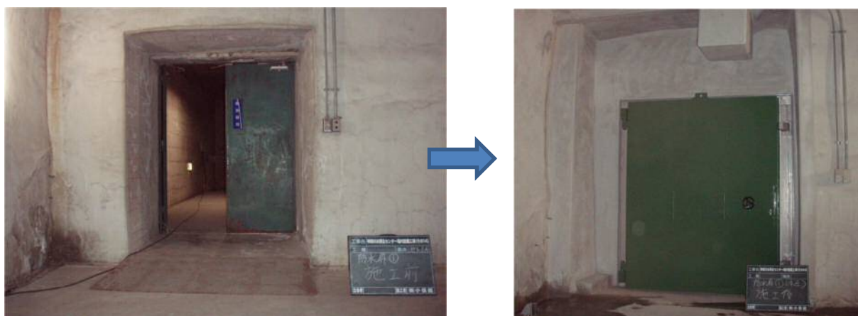
図 3-3 防水扉への更新
