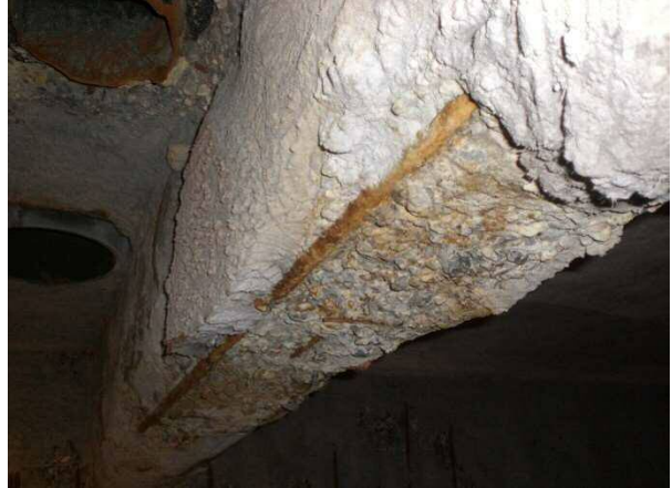
図 2-2 化学的侵食事例(濃縮汚泥受槽)
