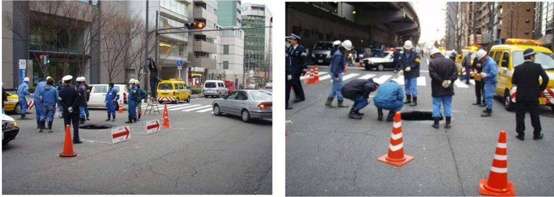
図 2-4 大阪市中央区での道路陥没状況
