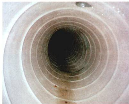
再生した下水管
