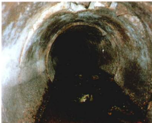
老朽化した下水管
