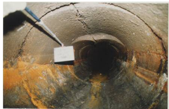
コンクリート破損
