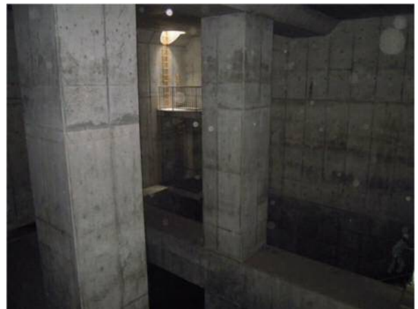
玉船雨水調整池 貯留量 13300t
