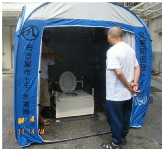
下水道直結式仮設トイレ
