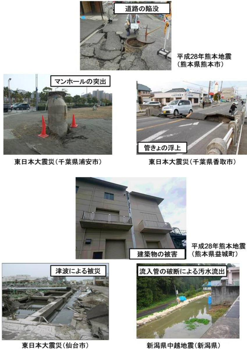
図 1-2 下水道施設の地震による被害
