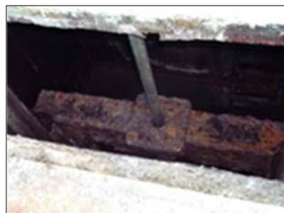
図 1-4 ゲート設備の腐食
