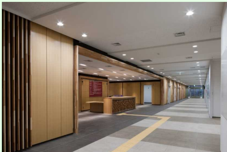
仙台第1地方合同庁舎増築棟 玄関ホール・受付(壁)
