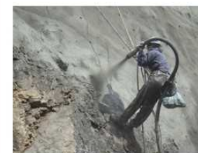
仮設用モルタル吹付状況
