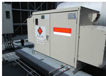
屋上に設置した非常用自家発電機
