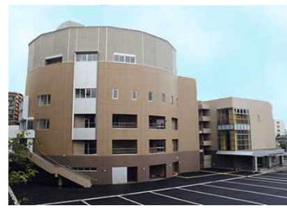
土樋キャンパス体育館外観（向かって右）
