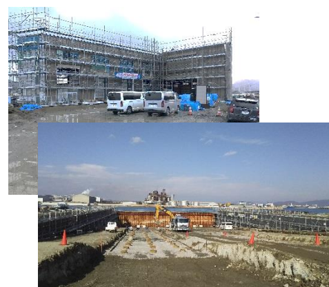
整備中の造船工場(石巻市)
