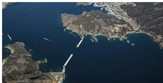
H29.2 大船渡港湾口防波堤全景
