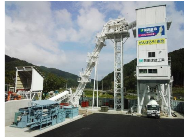
国交省仮設プラント(岩手県釜石市)
