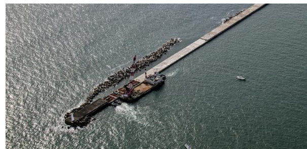
H28.3 相馬港沖防波堤工事状況
