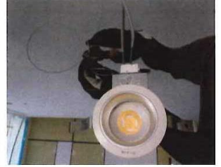
写真-天井下地と天井に付く部材をワイヤーで固定
