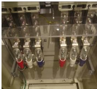
←2階に設置された電源供給口
