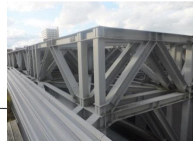
写真－鉄骨屋根
