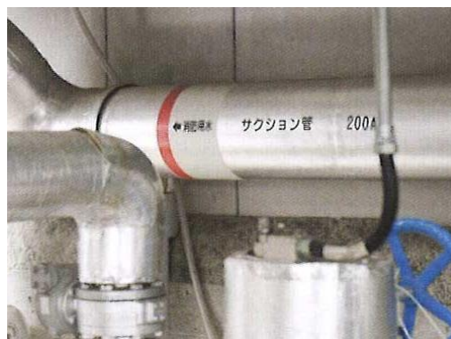
写真－蓄熱槽からの消火配管（晴海地区）
