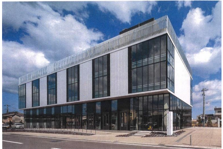
写真—いわき市地域防災交流センター 外観
