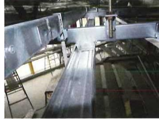
写真-クリップを使用しない天井下地工法
