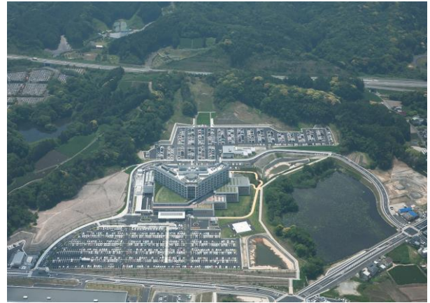
写真—中東遠総合医療センター外観
