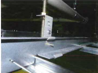
写真-クリップを使用しない天井下地工法
