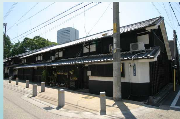
伝統的古民家を賃貸住宅に改修し、景観保全に貢献
