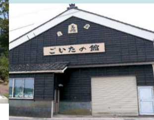
伝統芸能伝承の為の施設改修
