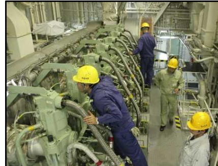
《機関点検等実習》
