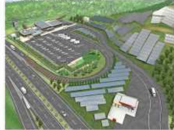
○太陽光発電設備
