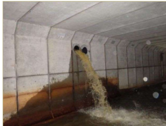
雨水管への越流状況
