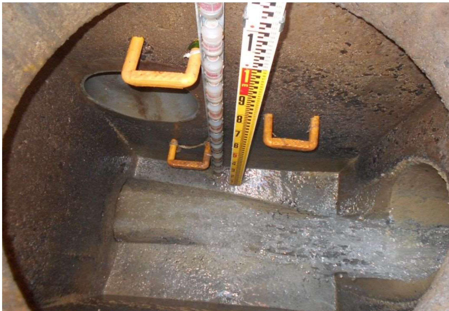
越流確認のための水位計測
