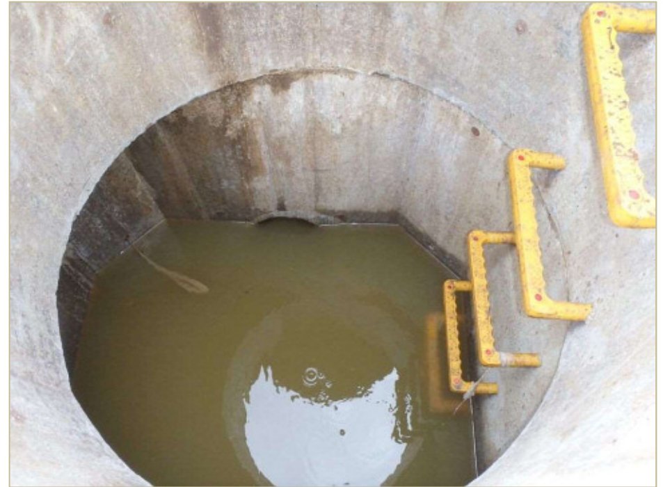
水が上がった状態
