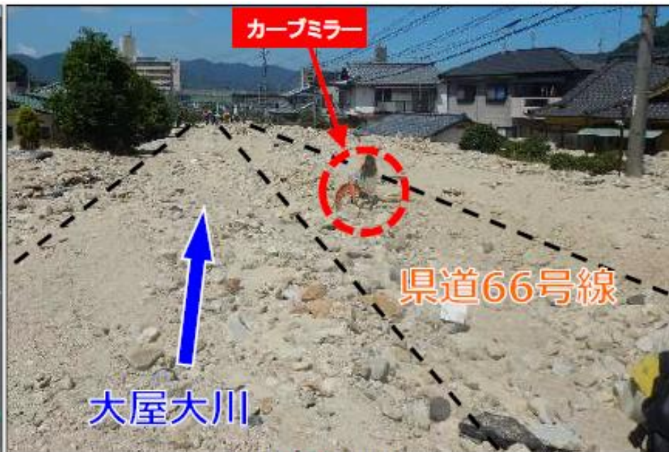
被災後状況写真
