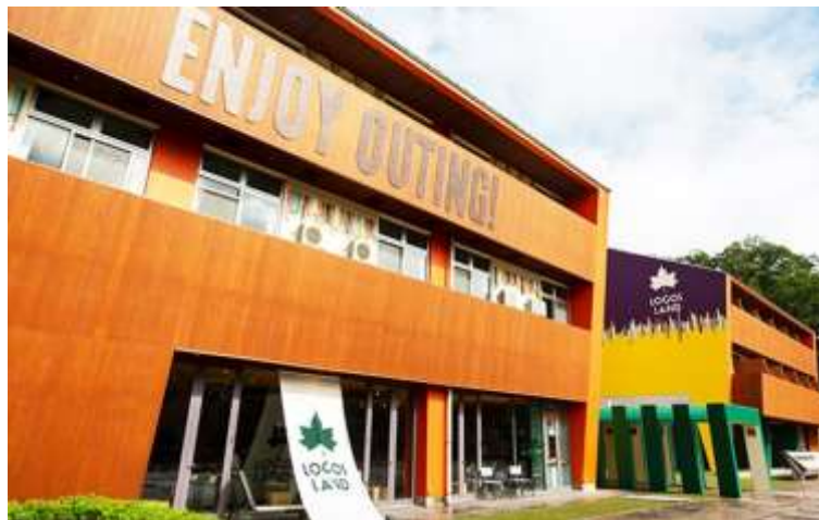
既存の宿泊施設をリノベーションしたホテル
