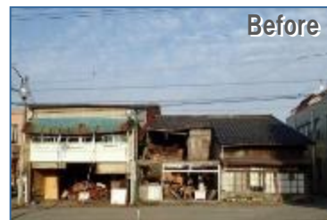
空き家の除却
