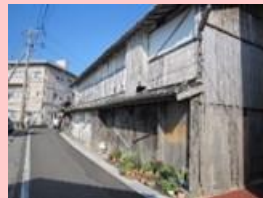
空き家の除却
