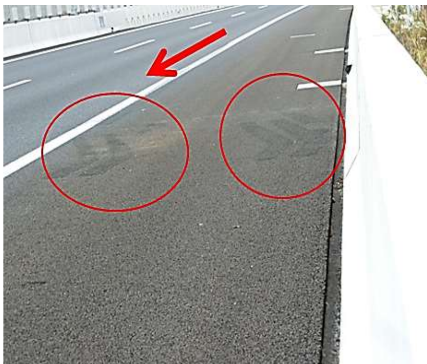
写真3-1 第1衝突地点 (○印 相手車両後輪痕)
