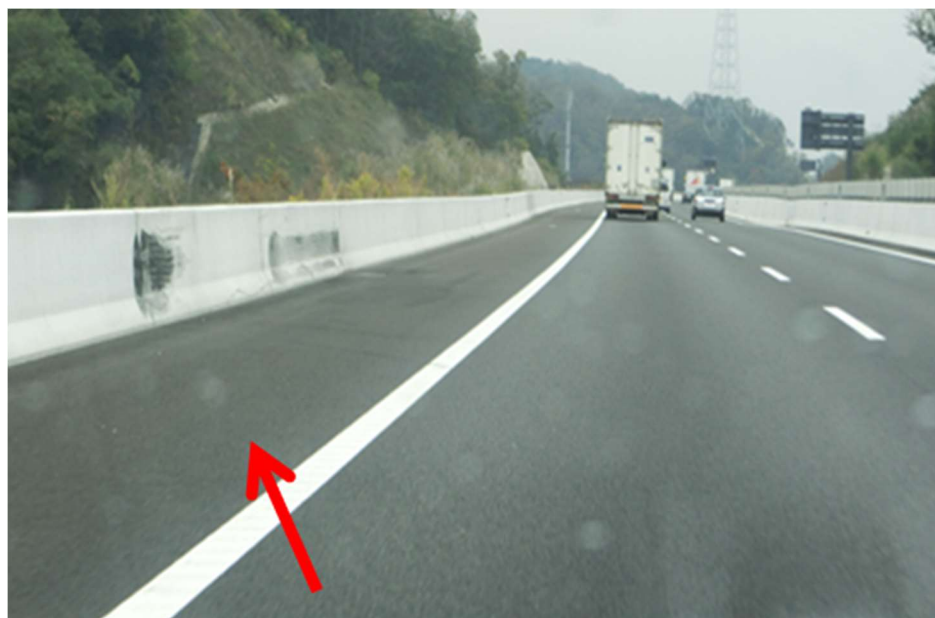
写真3-2 第2衝突地点 (事故地点より約27.3m前方)
