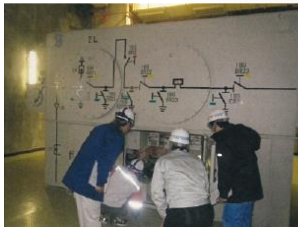
電気関係現地調査
