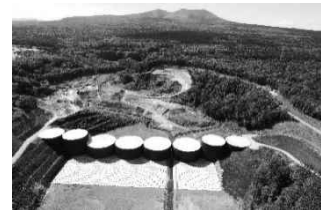
樽前山覚生川2号砂防堰堤（苦小牧市）
