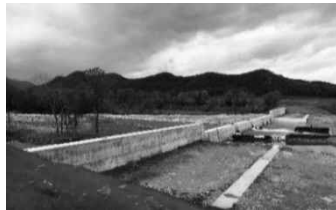
十勝川水系戸蔭別川第2号砂防堰堤（帯広市）
