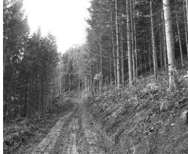
路網（森林作業道※ 2 ）の整備
