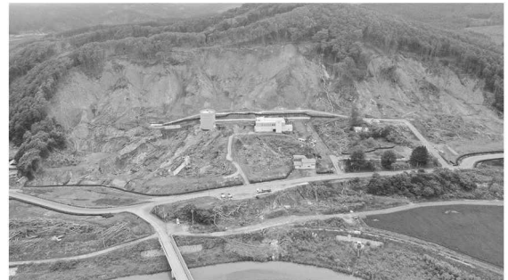
残留土塊除去作業が完了し、現在は法面対策工事等を実施中
