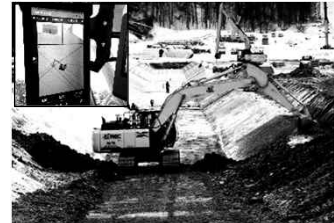
ICT建設機械による施工
