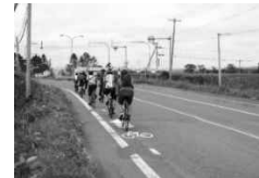
路面への通行位置明示
