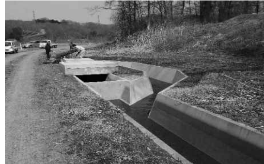
仮設水路による暫定的な用水の確保
