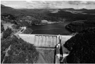
佐幌ダム（堤体かさ上げ予定）
