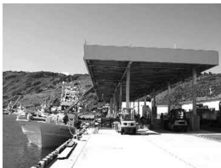
屋根付き岸壁
