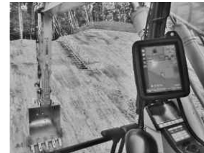
3次元データを活用した作業状況
