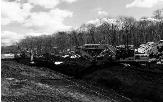
水路に堆積した土砂の撤去
