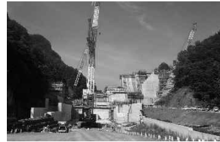
工事中の平取ダム（平取町）
