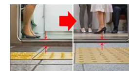
ホームの嵩上げ(段差の縮小)
