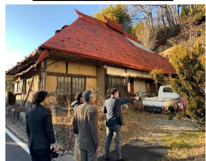
写真5. 現地視察の様子
