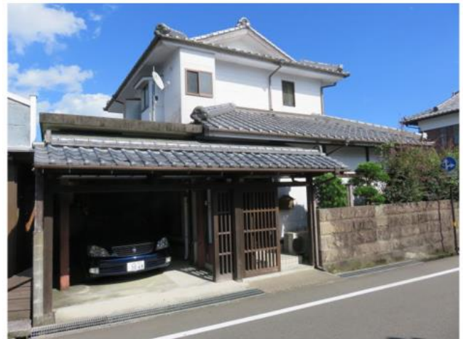
写真7 ワークショップ会場の空き家
