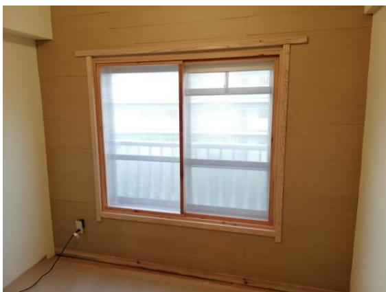
写真1 内窓の製作と断熱材貼り付け
