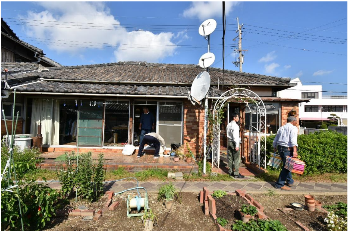
写真 1 空き家相談窓口にしつらえる作業の様子
