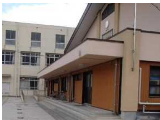
写真—改修後の体育館
