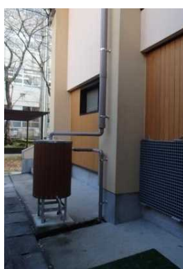
写真—雨水タンク
