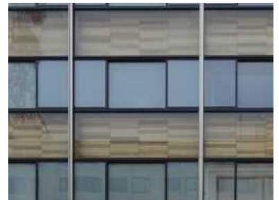
写真一道路側の外壁改修
