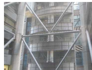
写真－東館制振ブレース
