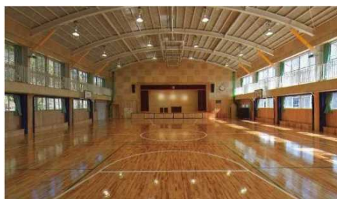
写真—アリーナの天井改修
