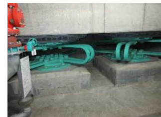
写真－西館 免震層
