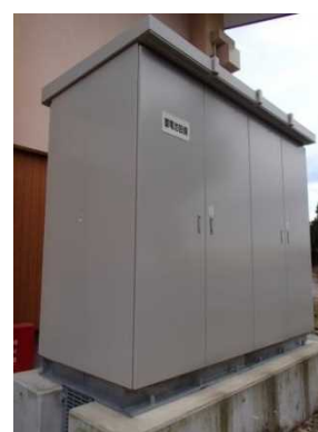
写真—蓄電池設備
