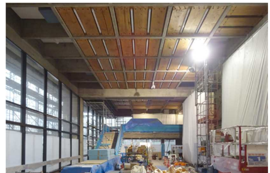
写真 - 高層棟ロビーの特定天井の改修工事
