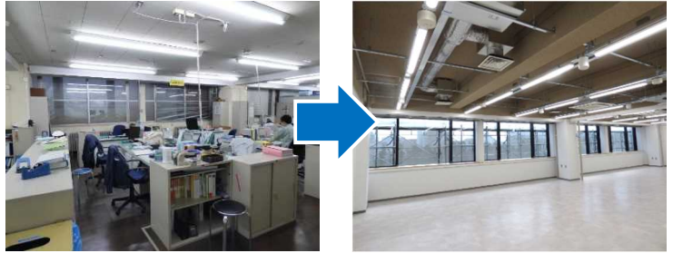
写真一執務室の直天井化（左：改修前、右：改修後）
