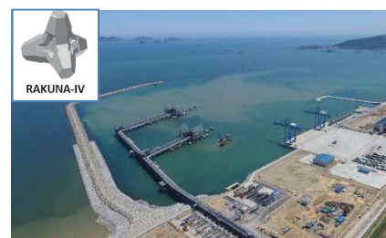
消波ブロックが採用されたニソン製油所建設
