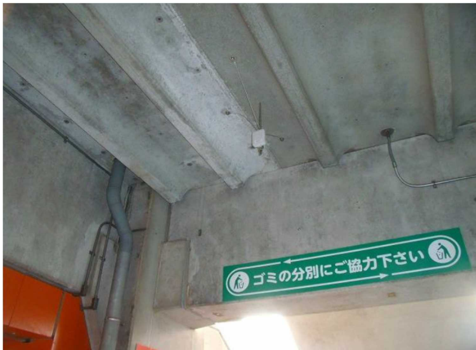
図 4.3.2-3 ビーコン設置例（日産スタジアム ワイヤーでの設置）
