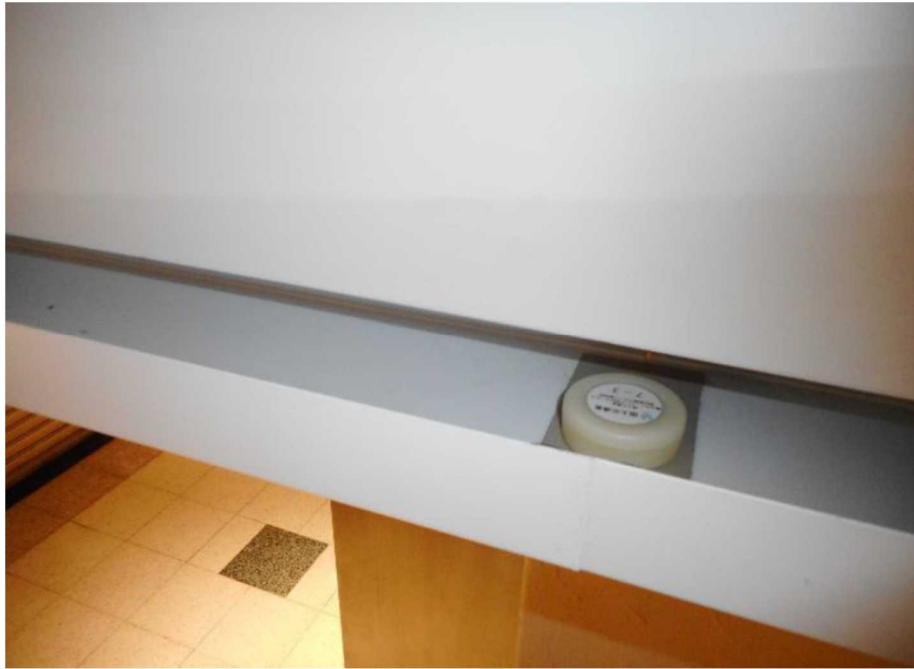
図 4.3.2-2 ビーコン設置例（新宿サブナード 既存の構造物の上面への設置）
