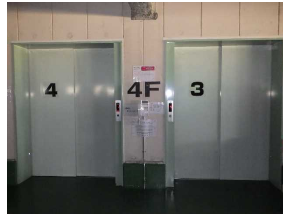
写真1 4階の乗場(左側が事故機)
