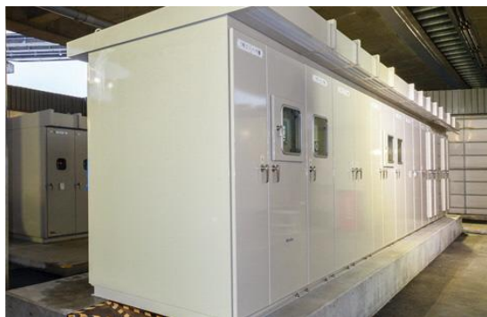
図 4-7 回生電力貯蔵装置設置イメージ
