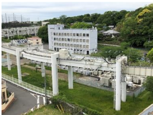
図 4-6 殿台変電所全景
