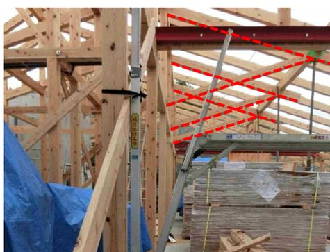
写真3 持出しトラス架構（赤線部）
