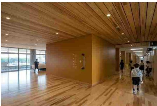
写真 4 内部天井（スギ目透かし張）
