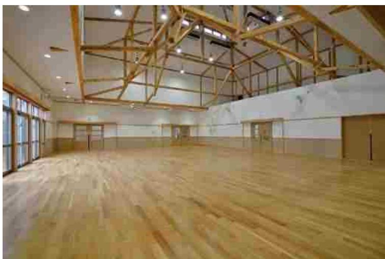
遊戯室の大空間は 183 m<sup>2</sup> (15.47m×11.83m) の大きさがあり、立体トラスで架構している。架構木材はすべて埼玉県産のスギ製材である。トラスに使用しているスギ製材はすべて流通サイズの木材であり延長は 6m 以内、材幅 120 mm、梁せい 120 mm～240 mmのスギ材を使用している。主に引張力が掛かる斜材部分には M-12 及び M-16 の丸鋼を使用している。最上部には 4 方向にハイサイドライトを設けて明るい天空採光を室内に取り入れている。
