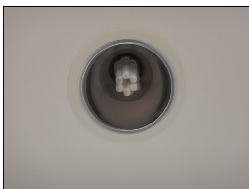
■LED照明の導入
