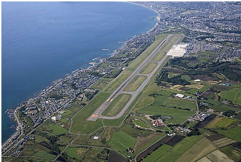
■函館空港の全景
