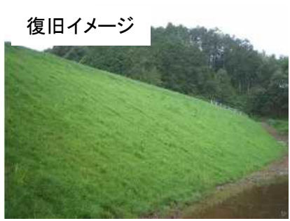
築堤工と併せて、法肩排水処理を設置
