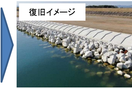
護岸工(コンクリート護岸+根固め工)を実施
