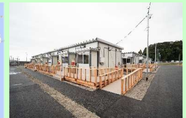
プレハブ住宅（輪島市完成事例）
