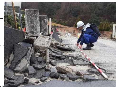
岩屋浄水場の被災（七尾市）
