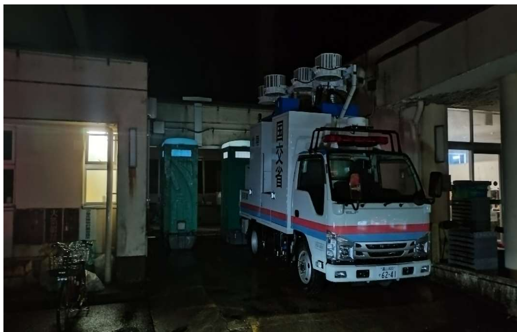
旧本小学校への電源供給
