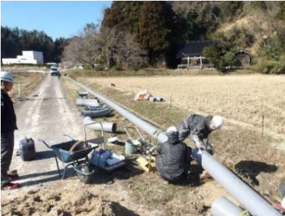
珠洲市 熊谷汚水中継ポンプ場から珠洲市浄化センターまでの仮設圧送管の布設（2/17）
