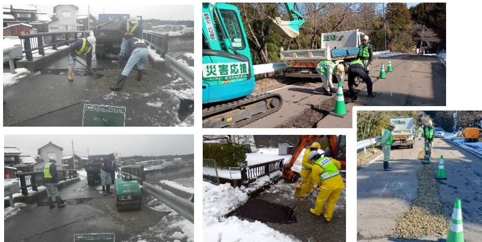
道路の段差解消作業
