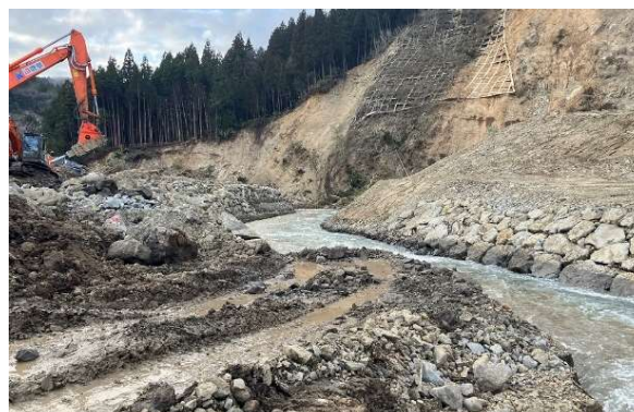
河道閉塞箇所 緊急工事
