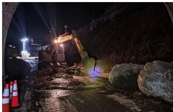
道路啓開 緊急工事
