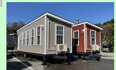
トレーラーハウス（設置例）
