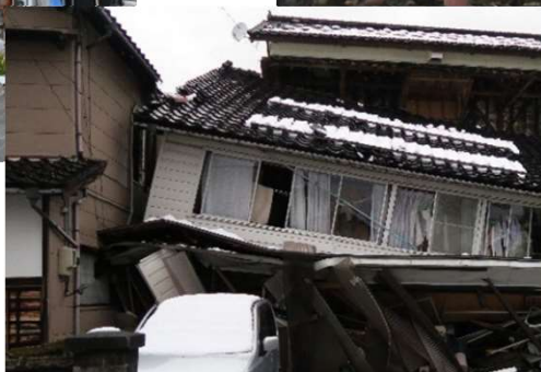
木造建築物の倒壊状況（穴水町）
