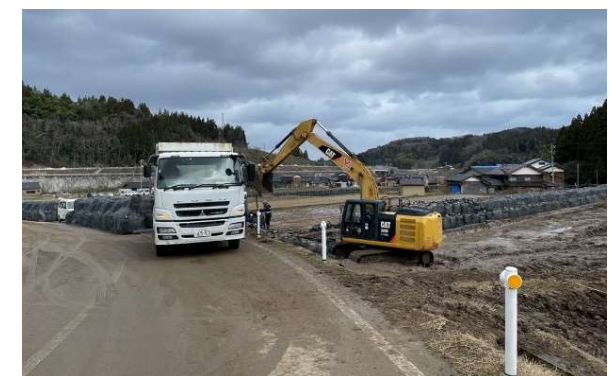
地すべり地区 緊急工事
