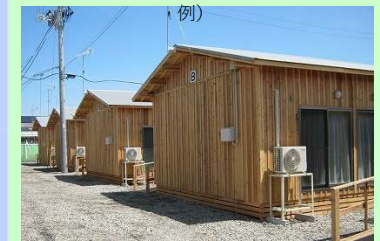
木造仮設住宅（設置例）
