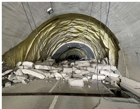
国道249号大谷トンネル（珠州市）
