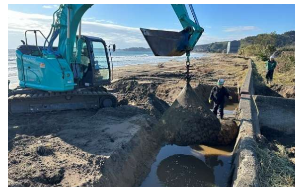
海岸施設 緊急工事
