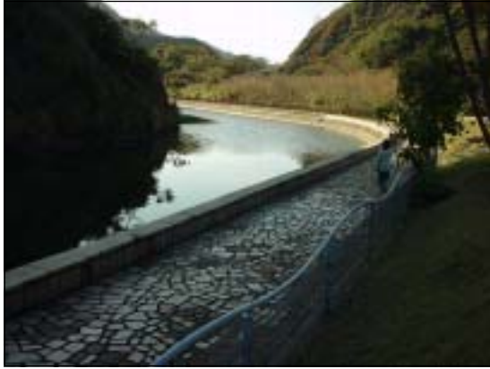
河川改修（ハッ瀬川）
