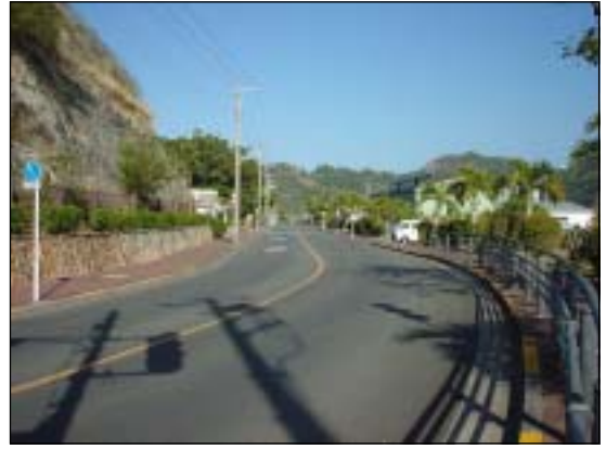
二見港前の道路整備状況
