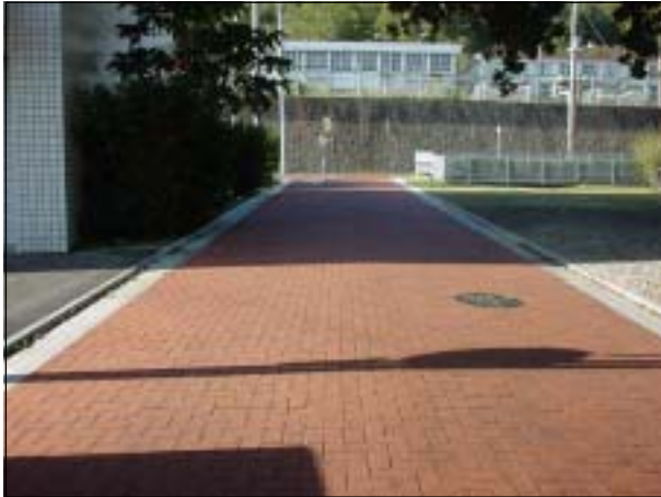
村道整備 (東町一号線)
