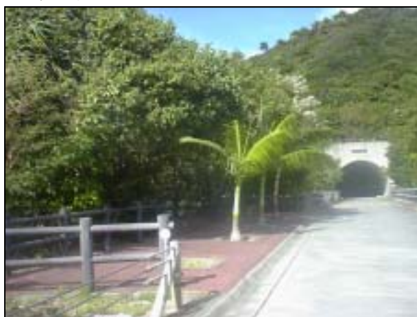
長浜トンネル
