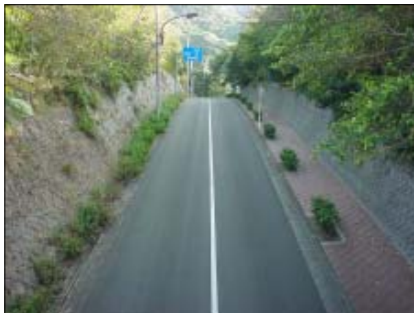
小港道路 (小曲付近)
