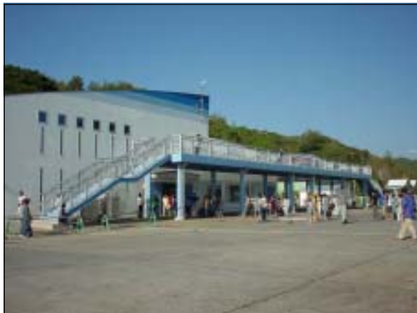
船客待合所（海側より）
