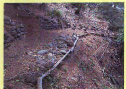
■ 危険箇所の歩道整備・改修
