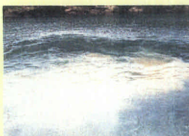
沖港:泊地浚渫
