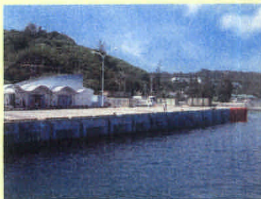
二見港:岸壁改良
