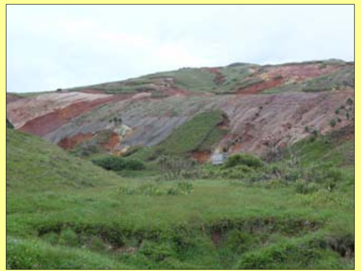
実施後(植生基盤保護シート施工)
