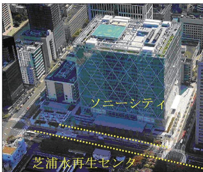
芝浦水再生センターと隣接するソニーシティ
