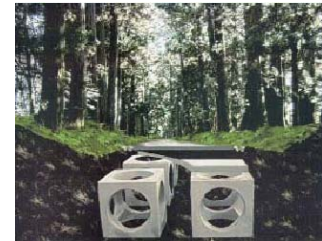
日光杉並木のポカラ工法 「JICE リポート第 2 号」 ／(財)国土技術研究センター
