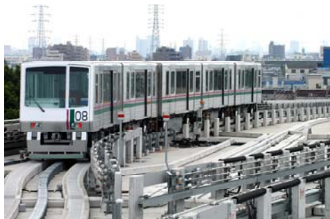
インフラ補助制度により整備を実施した新交通システム （日暮里・舎人ライナー 東京都） ※H20. 3. 30開業予定
