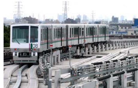
インフラ補助制度により整備を実施した新交通システム (日暮里・舎人ライナー 東京都)
