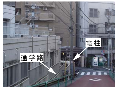
【通行の支障となっている電柱】
