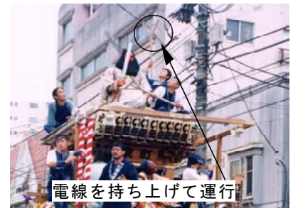
【祭りの支障となっている電線】
