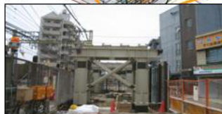
○「抜本対策」連立事業中対策： 工事中仮線路の高架化
