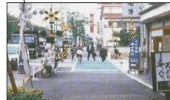
○「速効対策」踏切横断円滑化： 踏切拡幅
