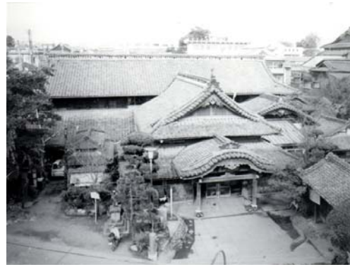
昭和48年・解体直前のさくら湯
