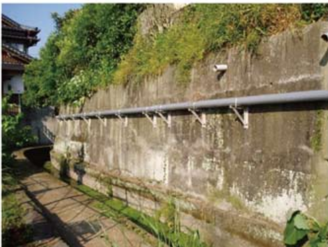
露出配管の設置状況
