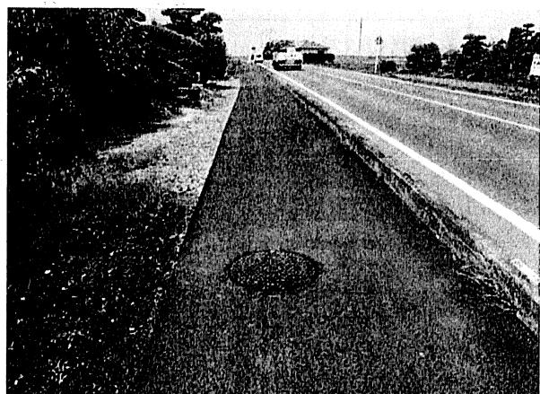
写真-3 改良型伏越しの連続的採用の竣工状況
