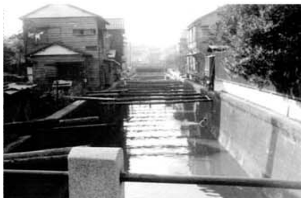
工事施工前（昭和38年9月）
