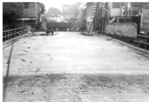
工事施工後（昭和39年2月）
